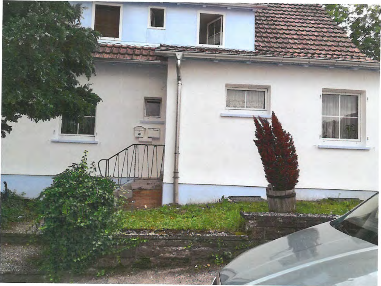
Bild 2: Endergebnis der Fassadensanierung
