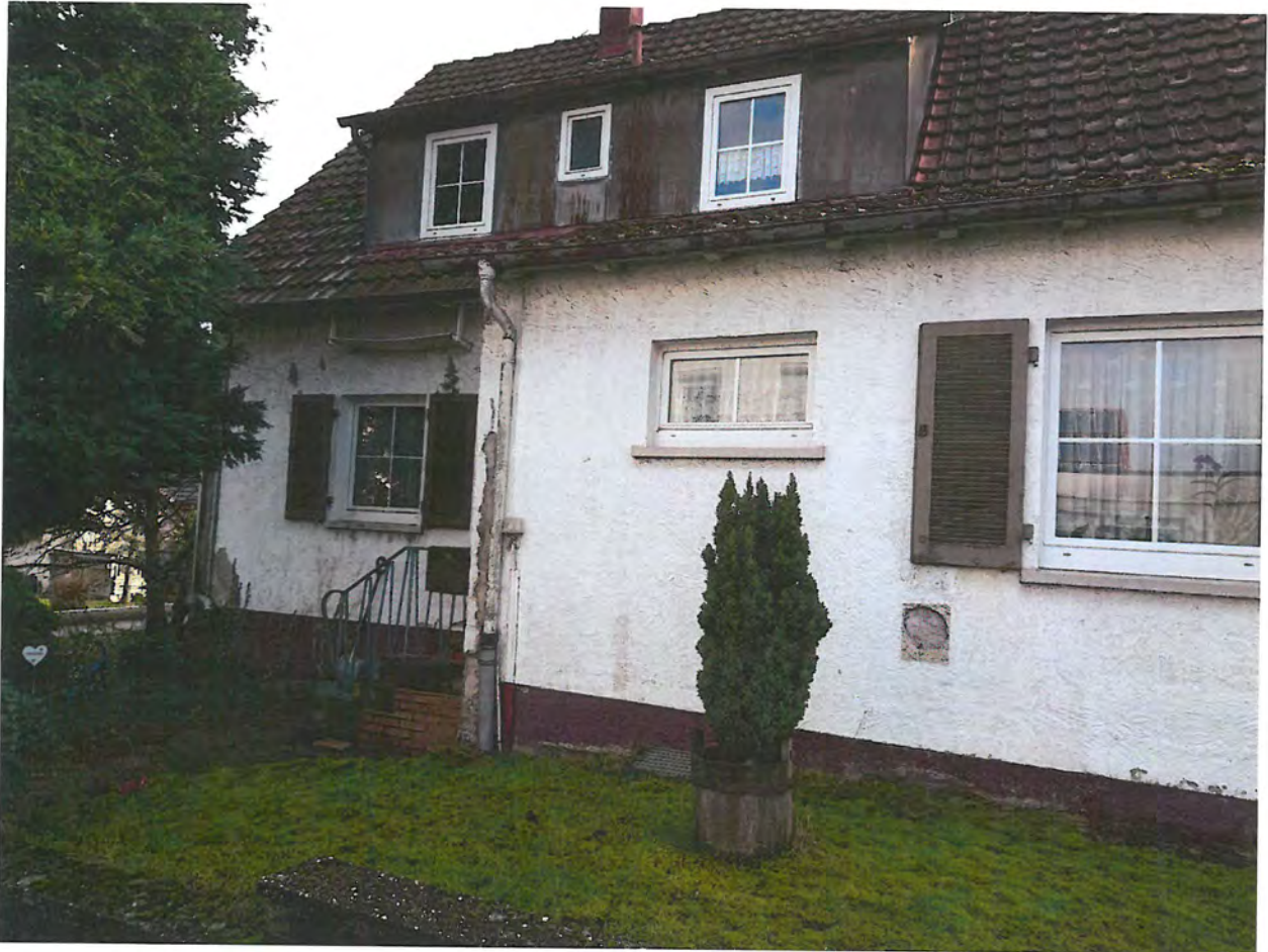
Bild 1: Ursprungszustand der zu sanierenden Fassade
