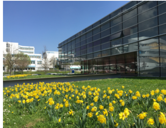
Das HLRS-Gebäude im Frühling (Foto: HLRS)
